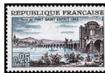
Rhone Bridge, Pont-Saint-Esprit — A454
